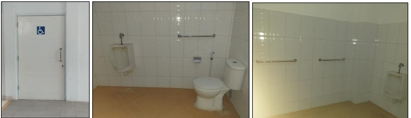
Gambar 5. Toilet khusus Difabel samping ruang sidang utama
