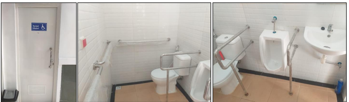
Gambar 6. Toilet Difabel sebelah depan gedung
